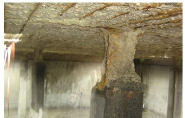
La solución más práctica es dotar de un sistema de aireación eficiente al tanque, cuando es posible o, de otra manera, no encapsular el agua residual. En Ciudad de México, por ejemplo, se teme a una posible falla masiva estructural de las antiguas tuberías del alcantarillado que ya empiezan a hundir vías a causa de este fenómeno.
