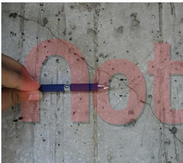
↑ Foto 3. Fisuración del concreto común en tanques de agua.
