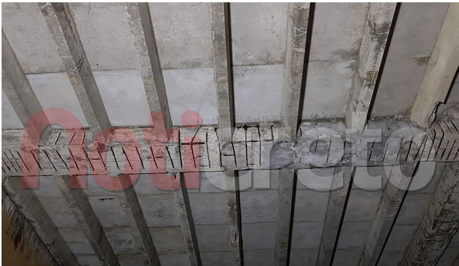
↑ Foto 1. Corrosión por ataque de cloruro gaseoso en la cara inferior de la losa de cubierta de un tanque de agua potable.
