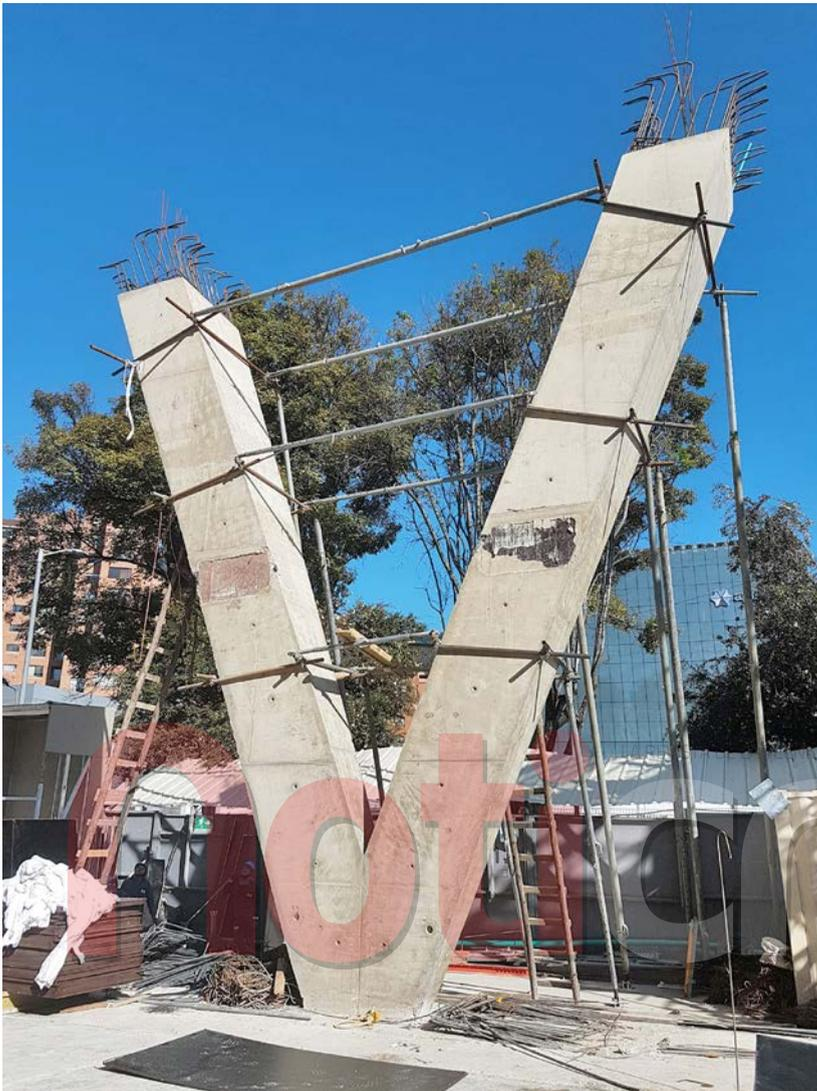
mucho más exigente, en especial para que las diagonales no interfirieran la flexibilidad del espacio. De otra parte, la eficiencia de los sistemas de malla *Diagrid* está muy ligada a su aplicación en el perímetro de la edificación, de tal manera que implícitamente se convierten en la misma fachada y en la imagen de la arquitectura. Una imagen muy singular, pues se distancia de la tradicional solución de pórticos.
