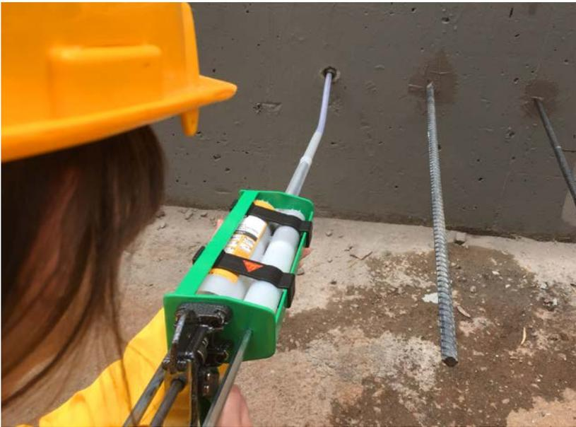
↑ Foto 2. Aplicación de adhesivo químico dentro de una perforación (adhesivo epóxico de dos componentes) mediante el uso de una pistola manual. CORTESÍA SIKA COLOMBIA S.A.S.
