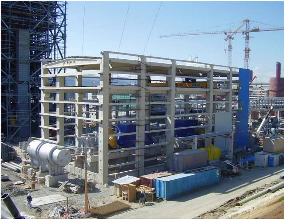
← Foto 5. Edificación industrial con prefabricados de concreto.
