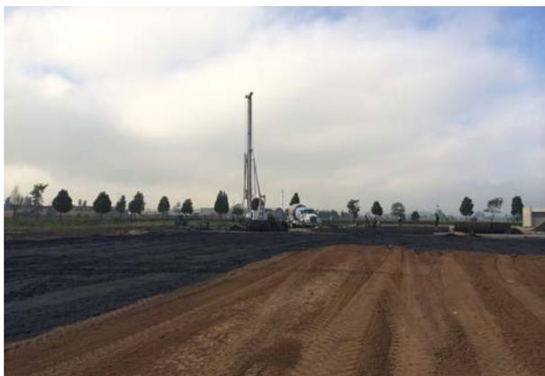
↑ Foto 6. Proceso constructivo de rellenos en ceniza e inicio del pilotaje.
