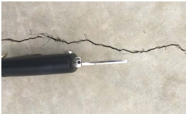
↑ Foto 3. Fisuras de retracción por secado.
