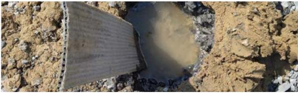
← Foto 5. Dren vertical tipo mecha instalado.
