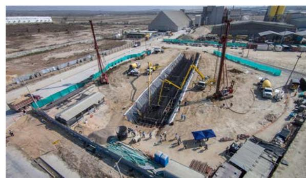
de mejorar el suelo mediante columnas de módulo controlado (CMC), con la óptica de reducir los costos de obra y asegurar la reducción óptima de los asentamientos del suelo.
