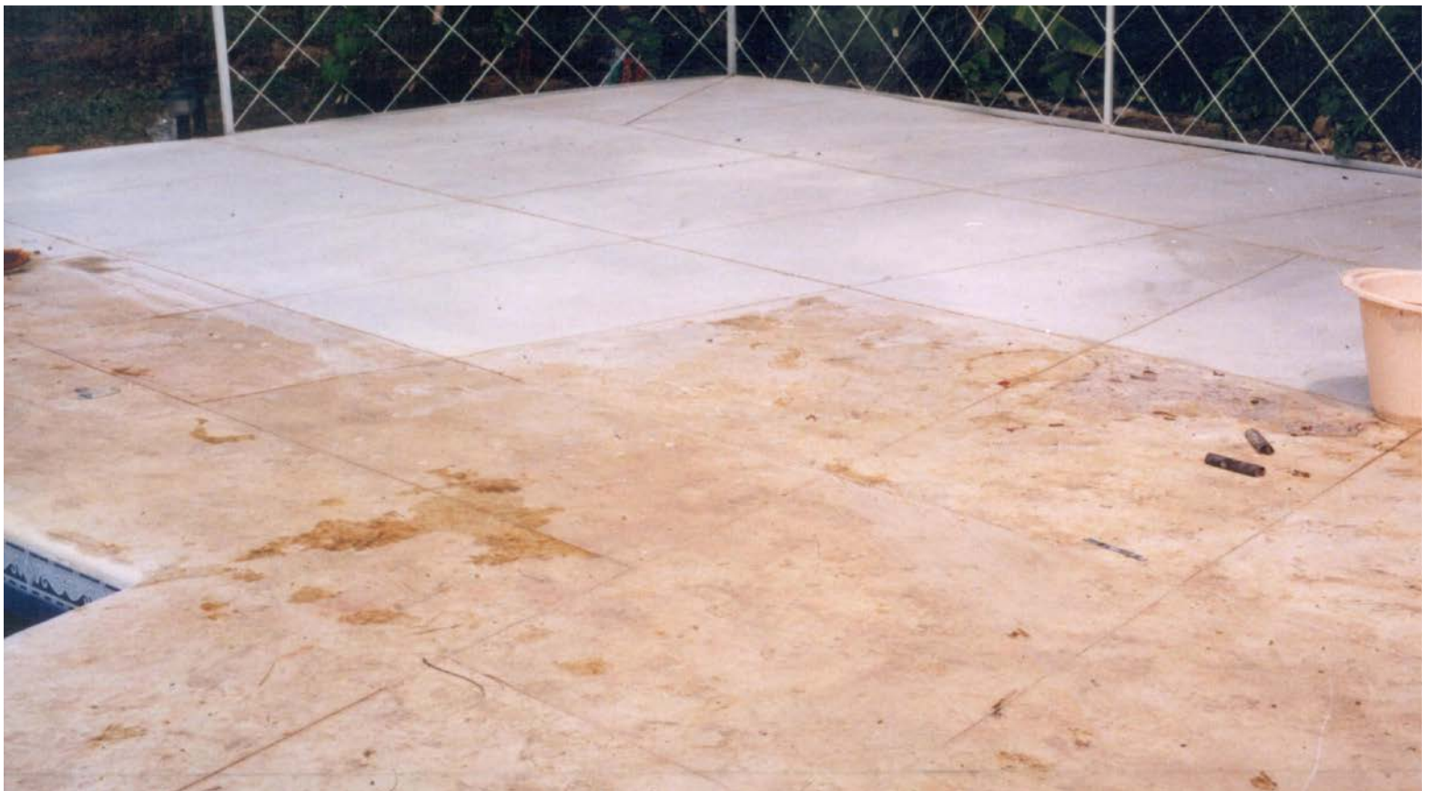
Foto 3. Limpieza superficial de losa en concreto blanco.
