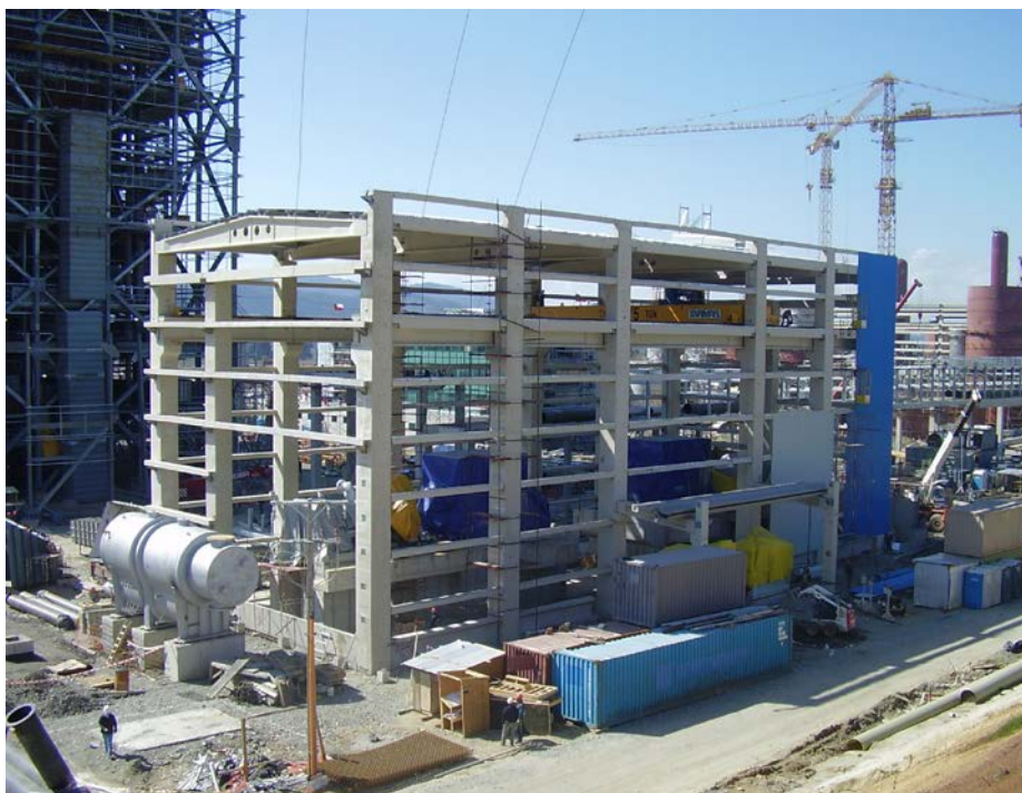
← Foto 5. Edificación industrial con prefabricados de concreto.
