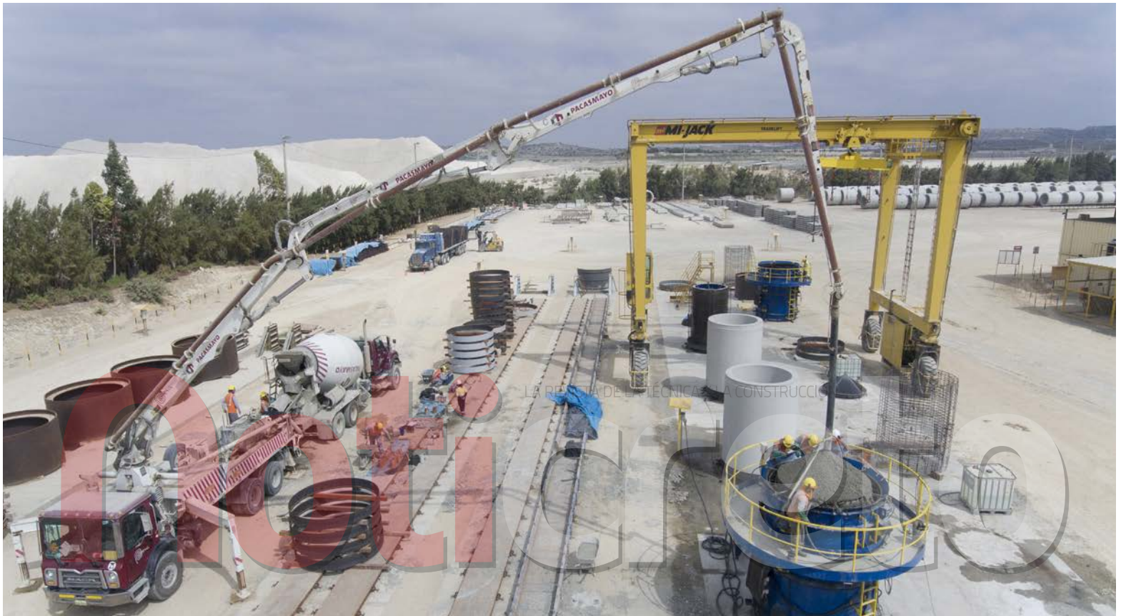
↓ Foto 6. Vaciado de concreto.
