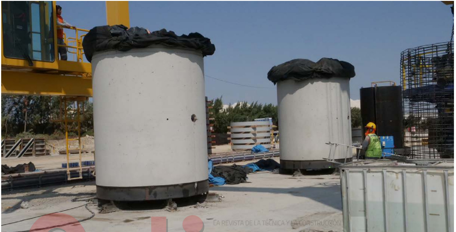
↓ Foto 2. Inicio del curado intermedio con malla geotextil.
