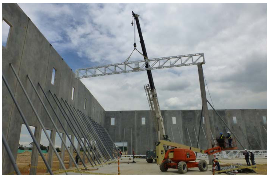
↓ Foto 3. Izado y apuntalamiento de paneles prefabricados.
