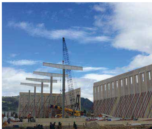
↑ Foto 7. Izado de paneles BMP. ÁREA DE INFRAESTRUCTURA. QUALA NOVA
