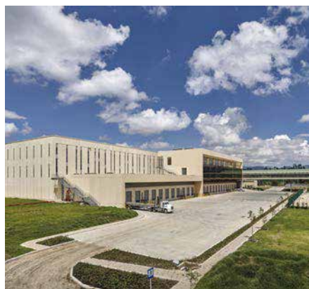
↑ Foto 3. Patio de maniobras en pavimento rígido del Centro de Distribución Nacional. ENRIQUE GUZMÁN GARCÍA
