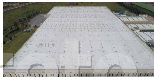
→ Foto 4. Vista en cubierta de los Sola tubes. ÁREA DE INFRAESTRUCTURA. QUALA NOVA
