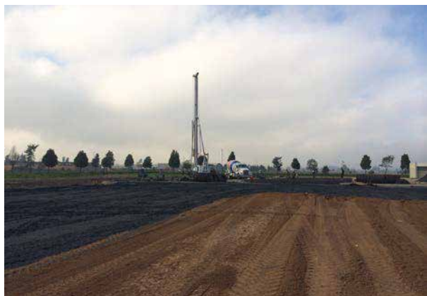
↑ Foto 6. Proceso constructivo de rellenos en ceniza e inicio del pilotaje. ÁREA DE INFRAESTRUCTURA. QUALA NOVA
