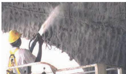
↑ Fig. 6: Aplicación de la celulosa-electrolito.
