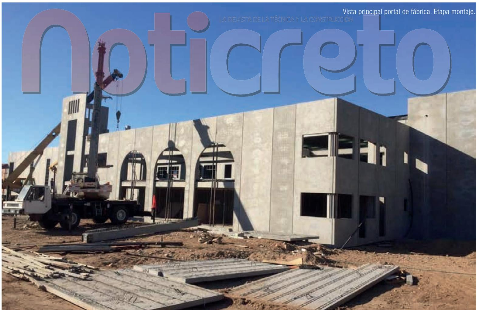
Evaluación integral con arquitectura, ingeniería, fabricación, transporte y montaje del 100% de piezas prefabricadas de concreto: fundaciones, vigas de fundación, pilares, viga portante y viga puntal, muros estructurales y arquitectónicos, costaneras y escaleras.
