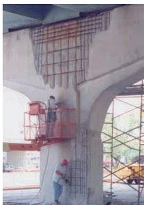
↑ Fig. 4: Remoción del concreto fracturado y delaminado.
