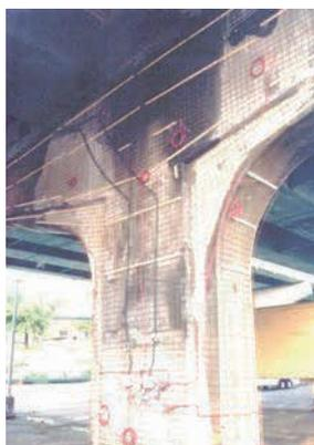
↑ Fig. 5: Instalación del ánodo externo temporal.
