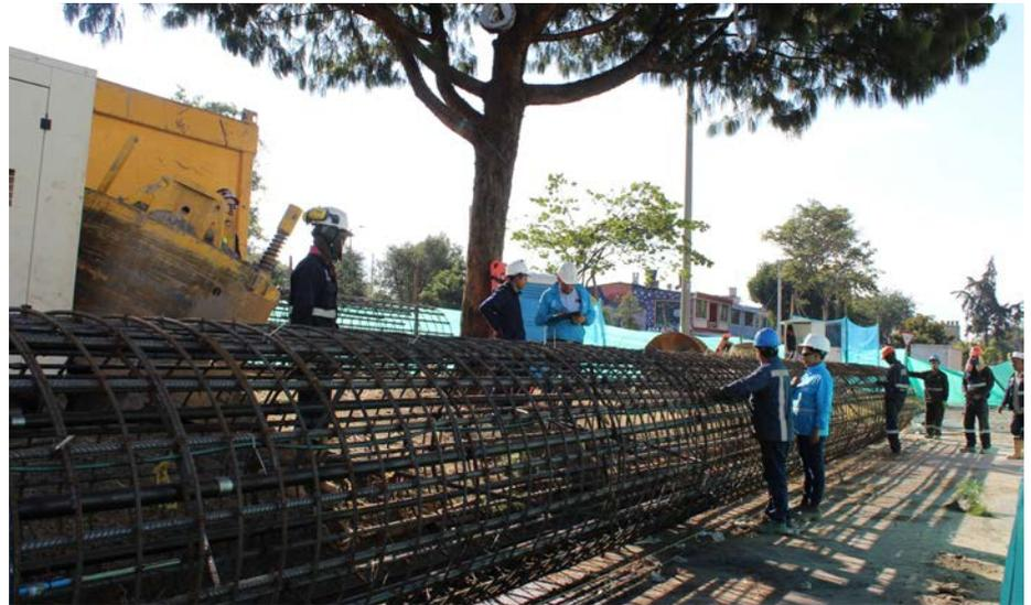
↑ Foto 2. Armado del pilote de prueba.
