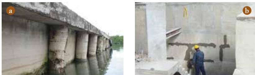
↑ a. Daños comunes en estructuras de concreto sumergidas y permeables, claramente debilitadas por alto grado de corrosión en el acero de refuerzo. b. Estructura enterrada bajo nivel freático, se usa mortero de reparación de rápido fraguado y sin contracción para aplicaciones verticales y sobrecabeza. TOXEMENT S.A.
