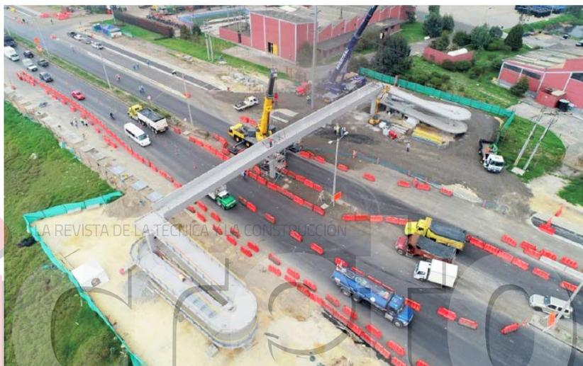
↑ Puente peatonal prefabricado sobre la vía Bogotá-Girardot.
