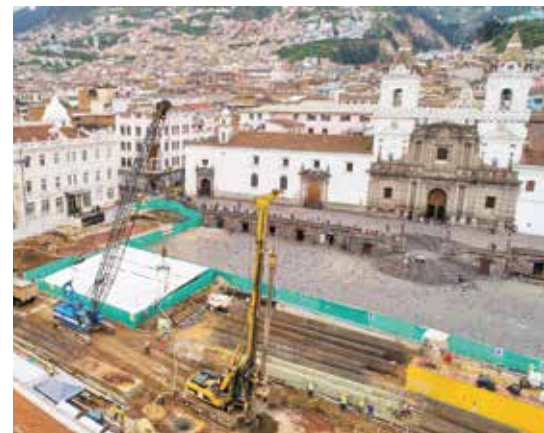
↑ Los pilotes fueron ejecutados con una piloteadora de 28Mtn de par de rotación.
