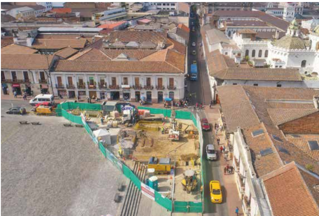
← Los accesos a la Estación San Francisco fueron ejecutados mediante un sistema de contención formado por una cortina de micropilotes.
