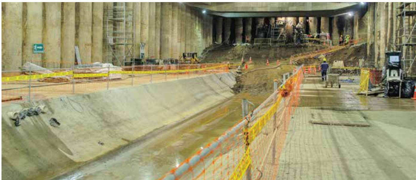
↑ No fue necesario ejecutar los pilotes secantes ni mejora alguna del terreno.
