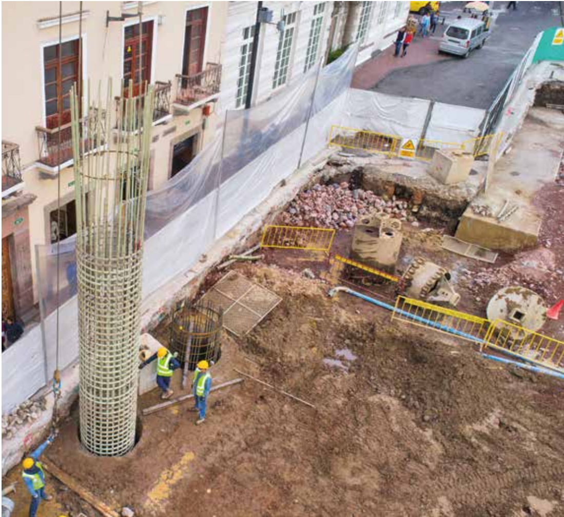
← Los pilotes alcanzaron una profundidad máxima de 35 metros.
