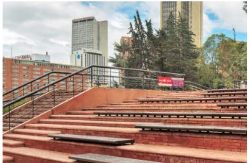
postensadas para asegurar la transmisión directa de las cargas a la superestructura del puente. Los remates laterales de las plataformas están conformados por muros de 15 cm de espesor de concreto arquitectónico que delimitan las pendientes y la geometría del espacio público.
