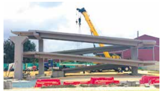
↑ Puente peatonal prefabricado sobre la vía Bogotá-Girardot.
