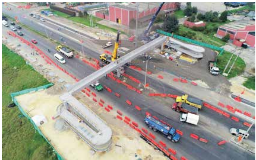
↑ Puente peatonal prefabricado sobre la vía Bogotá-Girardot.
