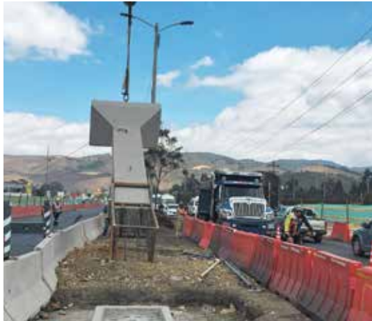
↑ Elevación de pilar e instalación del elemento.
