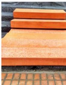
→ Escalón prefabricado de concreto.
