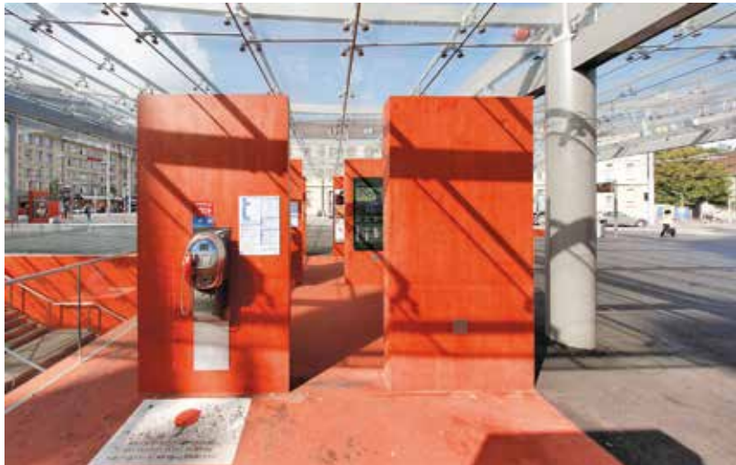
↓ Muros en concreto de color integral rojo, Beijing. SIKA COLOMBIA
